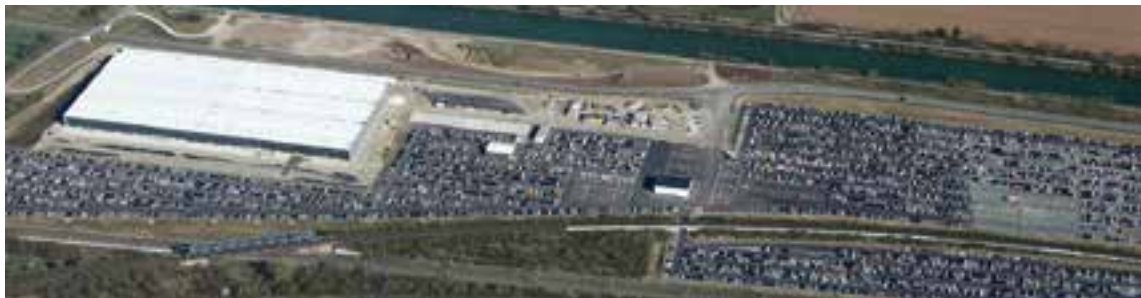
Aus der Luft betrachtet: das Multimodale Logistikzentrum an der Westrampe in Fallerleben
