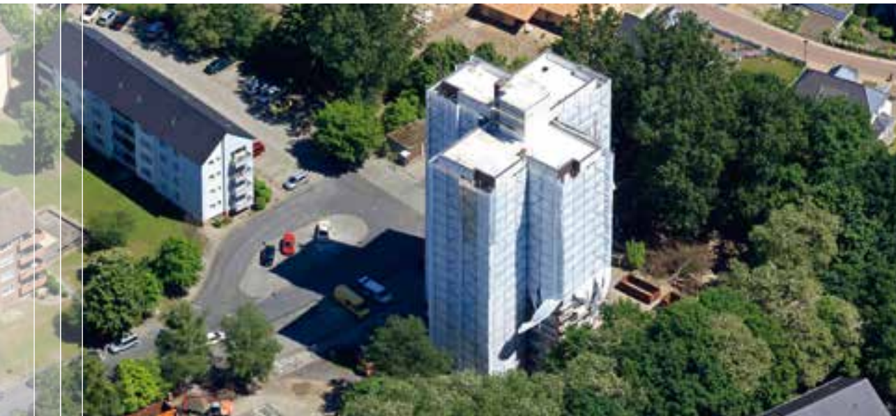
Der verhüllte Riese in der Drömlingstraße wartet auf die Bagger
